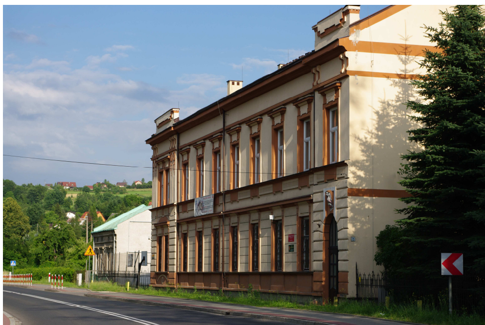
Fot. 2 Widok od strony północno – zachodniej.
