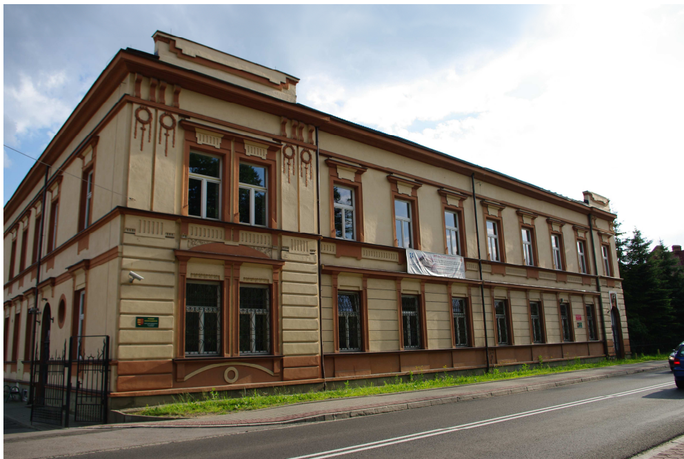
Fot. 1 Widok od strony północno – wschodniej.
