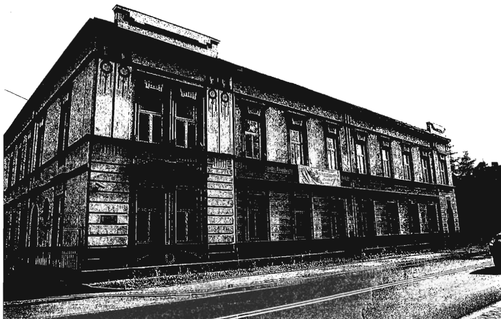
Fot. 1 Widok od strony północno – wschodniej.
