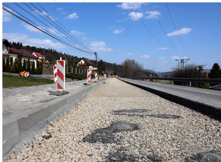
Remont drogi powiatowej nr 1551 K Limanowa – Chełmec
