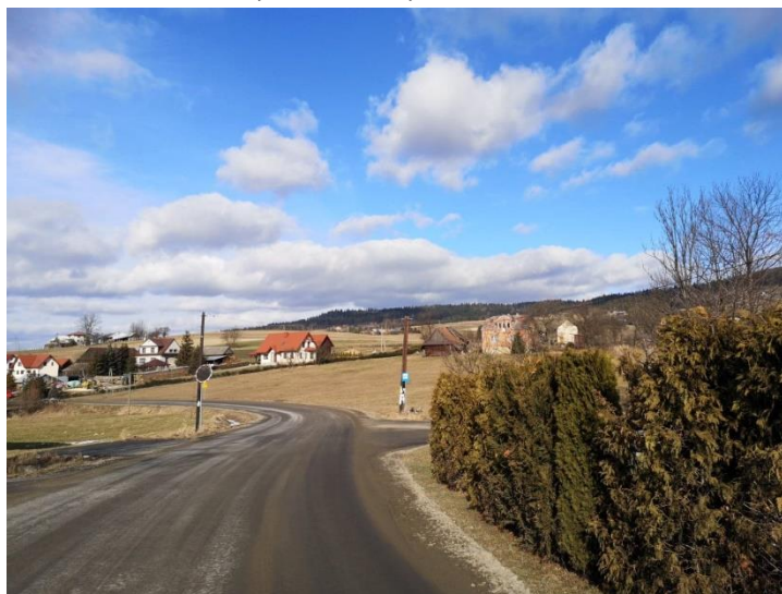
Remont drogi powiatowej nr 1505 K Ropa – Gródek – Biała Niżna
