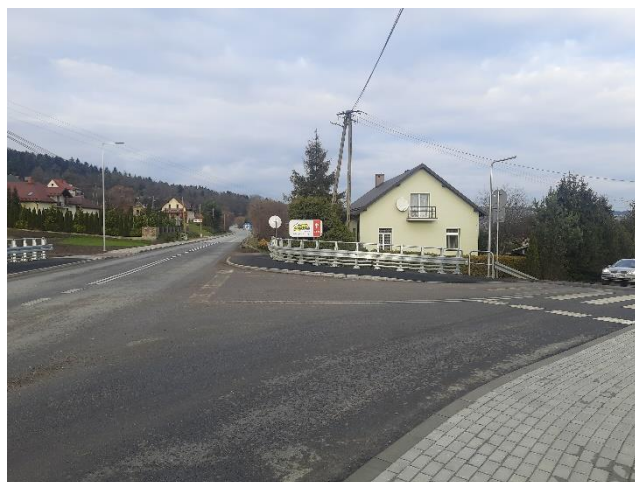
Budowa mostu w ciągu drogi powiatowej nr 1551 K Limanowa – Chełmiec wraz z przebudową skrzyżowania z ul. Jagodową
