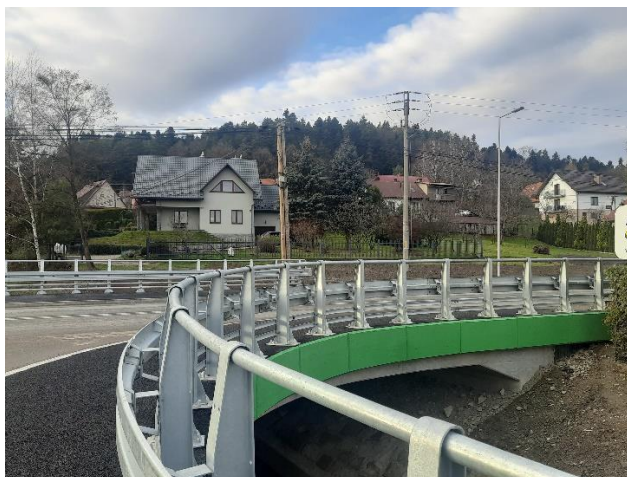
Rysunek 17. Wybrane zadania zrealizowane w ramach przebudowy i modernizacji mostów w 2022 r.
