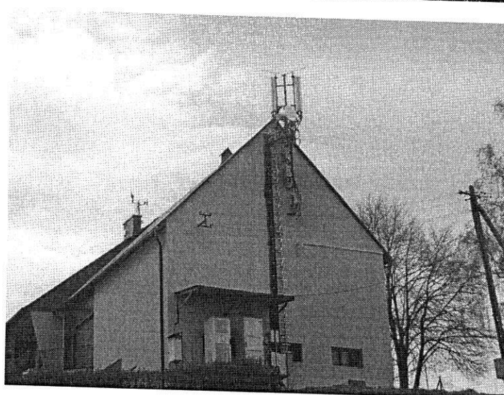
Zal. nr 1: Widok ogólny instalacji radiokomunikacyjnej.
